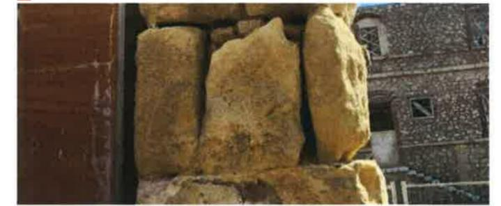
D: pilastre de la porte d'entrée constitué par des plaques de pierre en parement et d'un remplissage en maçonnerie de moellons.
