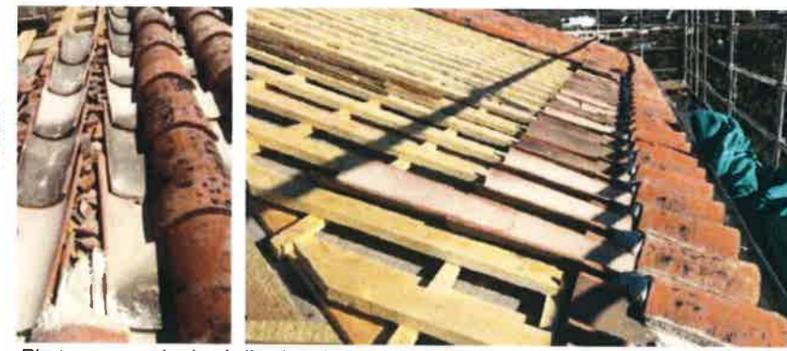
Photos: exemple de réalisation de couverture en tuiles canal scellées sur cassons de tuiles et voliges.
