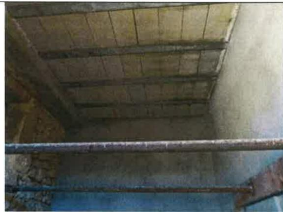
P02 Photo 2018: vue du plancher poutrelles haardis en béton mis en place pour la réalisation de la couverture du local transfo.
