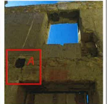
A: Poutre posée sur le sommier de la plate-bande ( disposition des poutres selon schéma 01) disposition d'origine.
